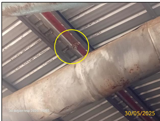
ภาพที่ 2.2-10 หัวฉีดพ่นน้ำแบบสเปรย์ในระบบ สายพาน
